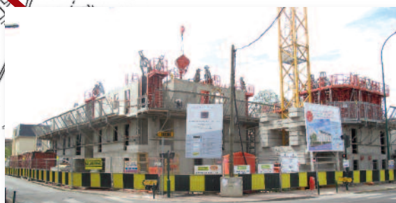
Un immeuble est en construction à la place du Parc du Pavillon Flore.
