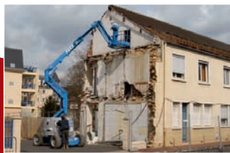
Béton à fond p. 2
